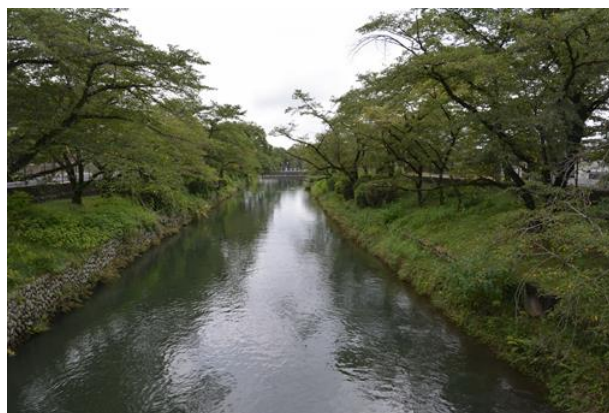
取水堰直下流の玉川上水と桜並木
