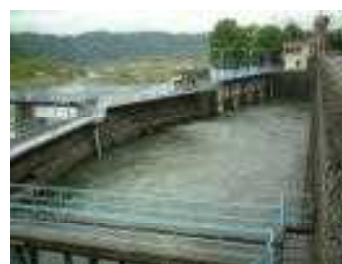
写真 10-b 羽村取水堰玉川上水側
