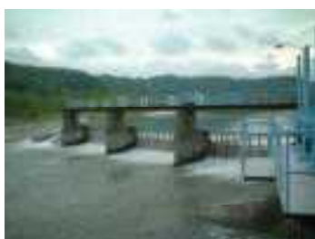
写真 10-a 羽村取水堰多摩川側
