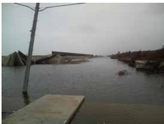
写真-1 防潮堤と洗掘された道路
