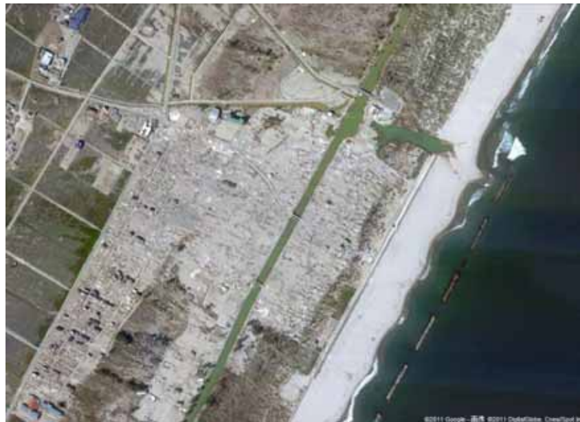
写真-3 仙台市荒浜地区 防潮林帯を宅地化した区域は、ほとんどの家屋が流失
