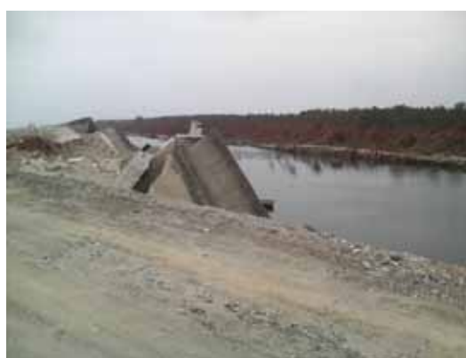
写真-1 防潮堤と洗掘された道路
